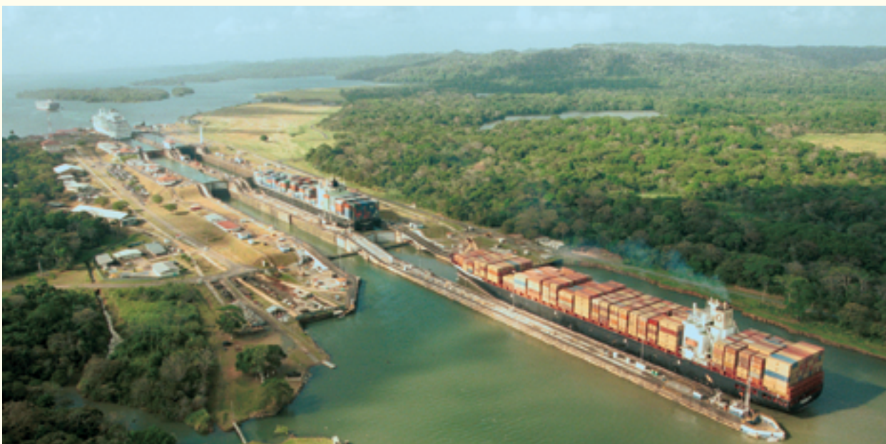
El Canal de Panamá - Infraestructura segura al servicio del comercio mundial
